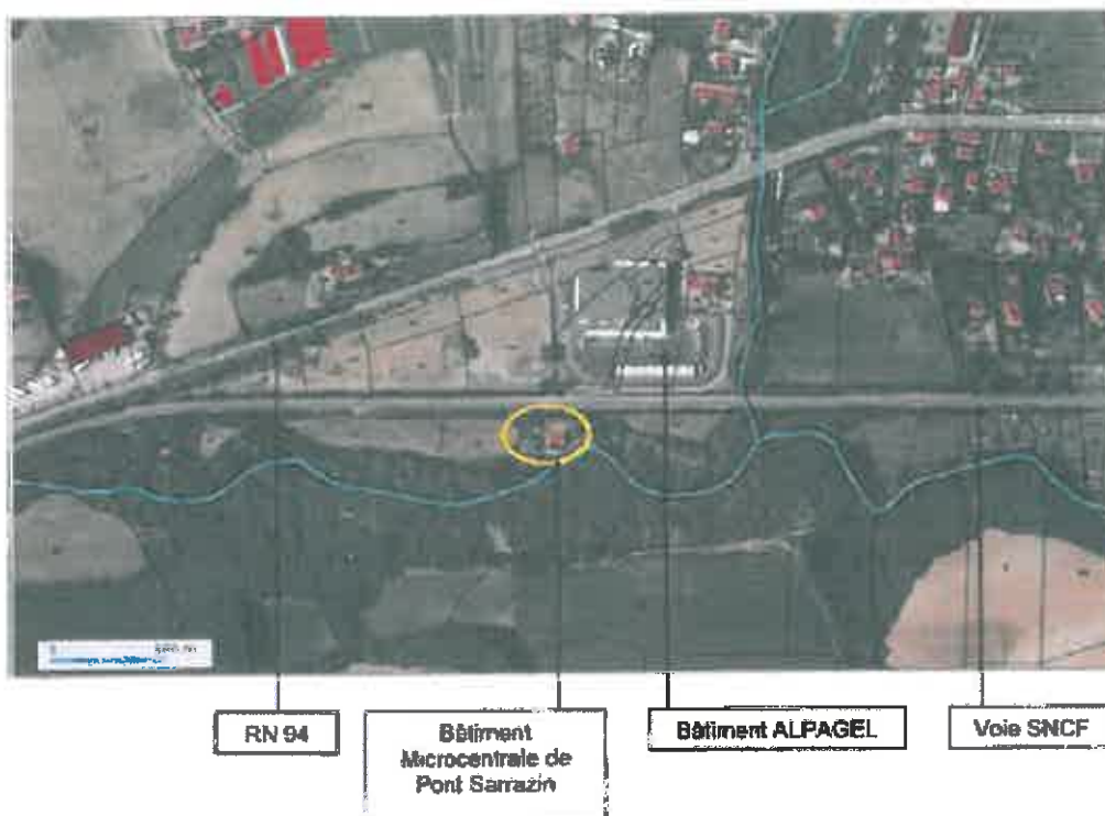
Fig. 4 : Situation de la centrale hydroélectrique sur la photo aérienne
