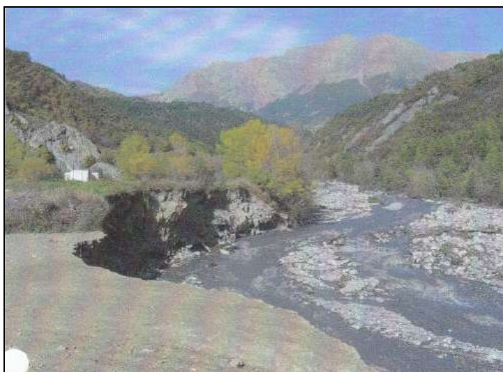
Figure 53 : Photo de l'ancienne décharge prise le 24/10/06 vers 10h [Source : RTM]
