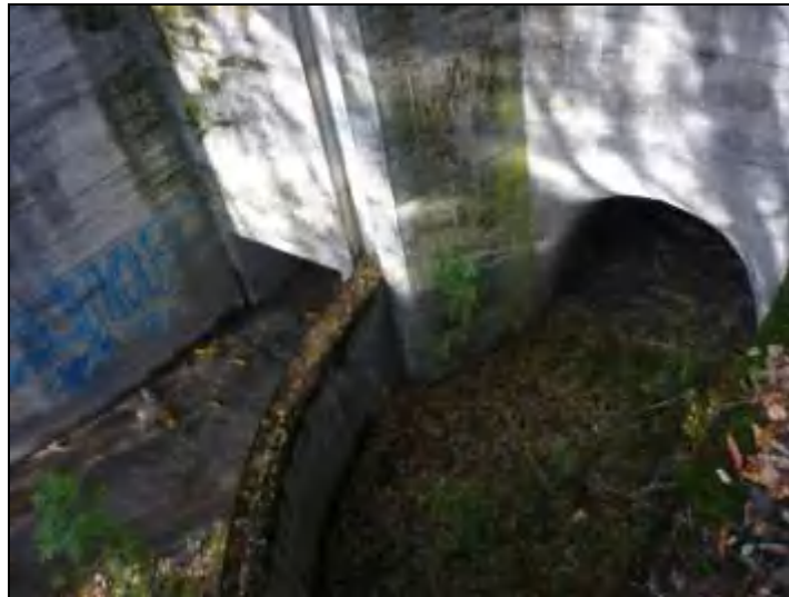
Figure 50 : Double passage busé dont l'un fonctionnant par surverse [Source : IMS RN ]
