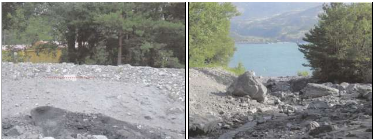
Figure 57 : Niveau de la lave sur la digue en RG, revanche d'environ 50 m (gauche) ; Blocs à proximité du lac de Serre-Ponçon (droite) [Source : RTM]
