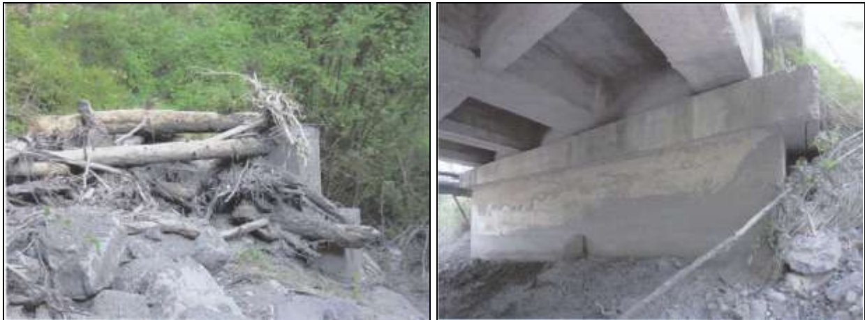
Figure 56 : Embâcle en rive gauche, provoquée par la culée de la passerelle (gauche) et hauteur de la lave sur la culée du pont de la RD (droite) [Source : RTM]
