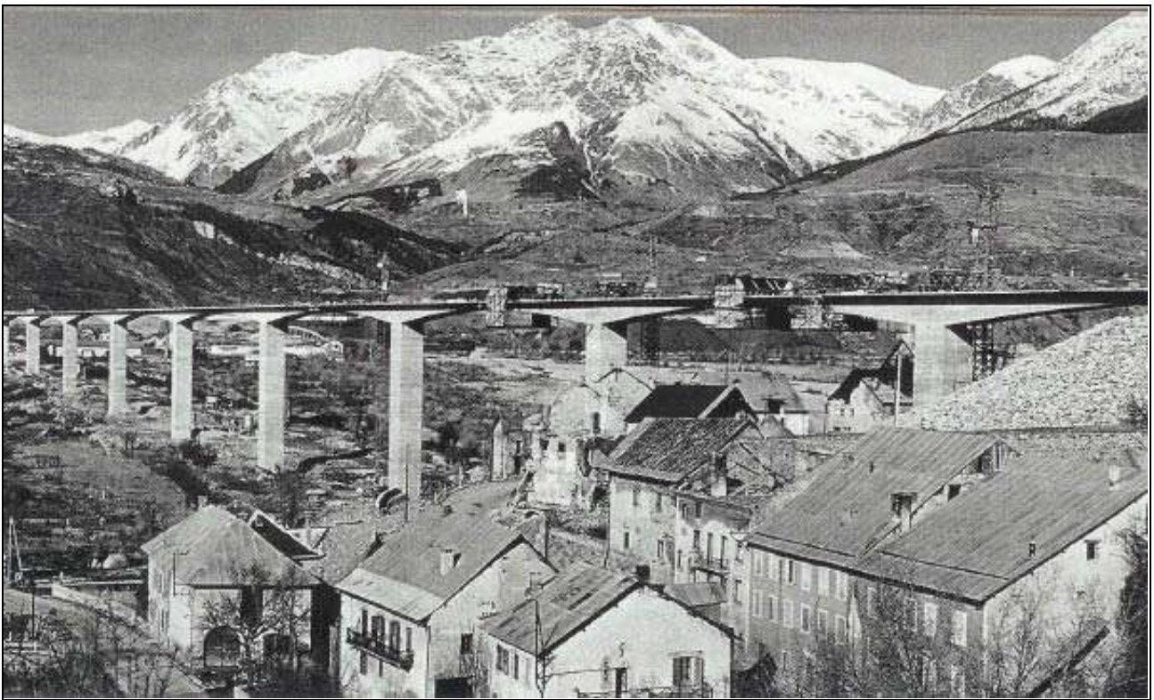
Figure 3 : Savines au moment de la construction du pont sur le lac de Serre-Ponçon
