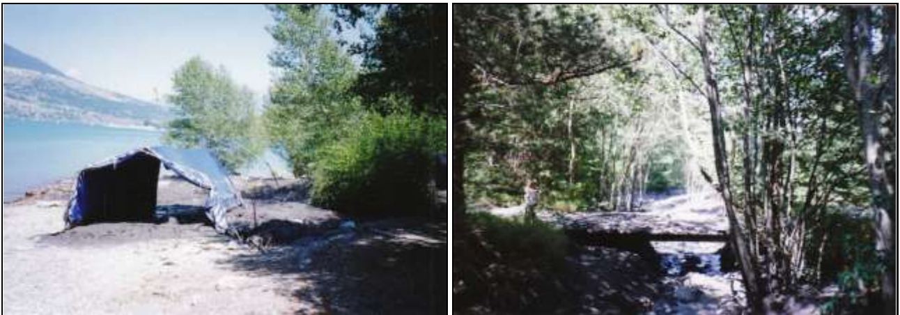
Figure 54 : Tente d'activité abîmée en rive gauche du torrent (gauche) ; passerelle entre le lac et la RD, la lave est passée au dessus (droite) [Source : RTM]
