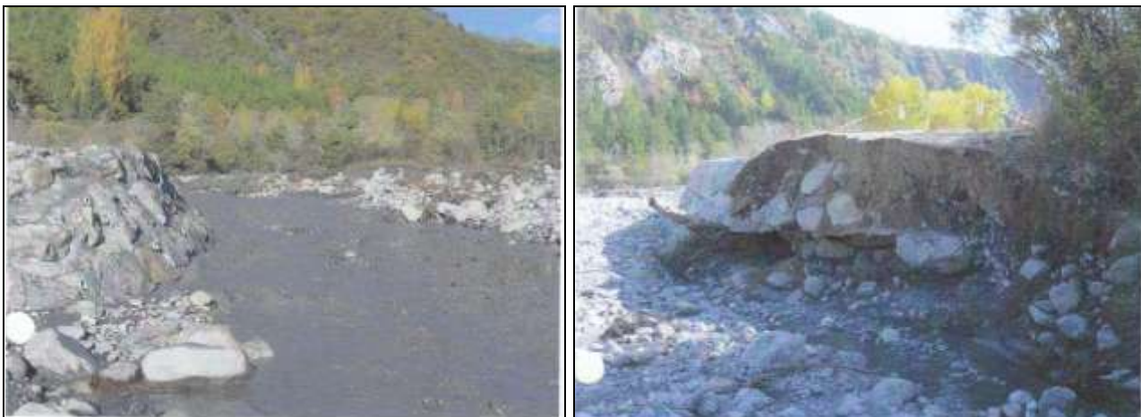
Figure 52 : Photos de la digue de protection de la déchetterie prises le 24/10/06 vers 10h [Source : RTM]
