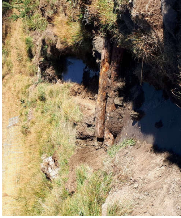
Pose de barrage pour stabiliser le remblai
