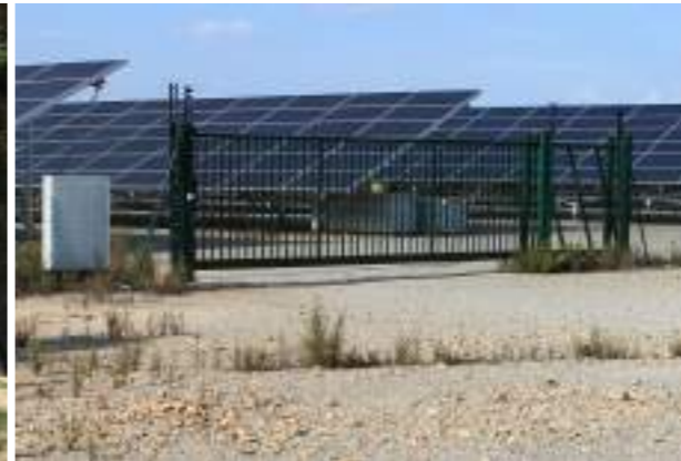
Portail et clôture
