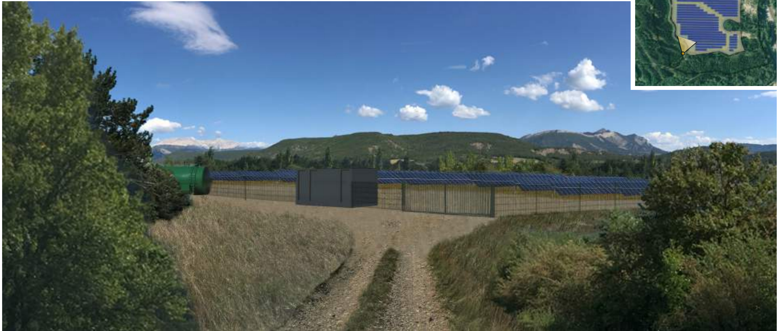
Vue depuis piste d'exploitation intérieure à 'Est
