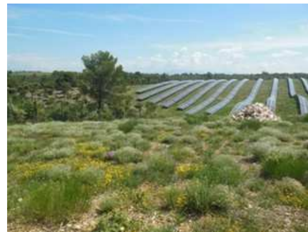
PHOTOGRAPHIE 18 : EXEMPLE DE DISTANCE INTER-RANGÉES ENTRE LES TABLES DE MODULES
