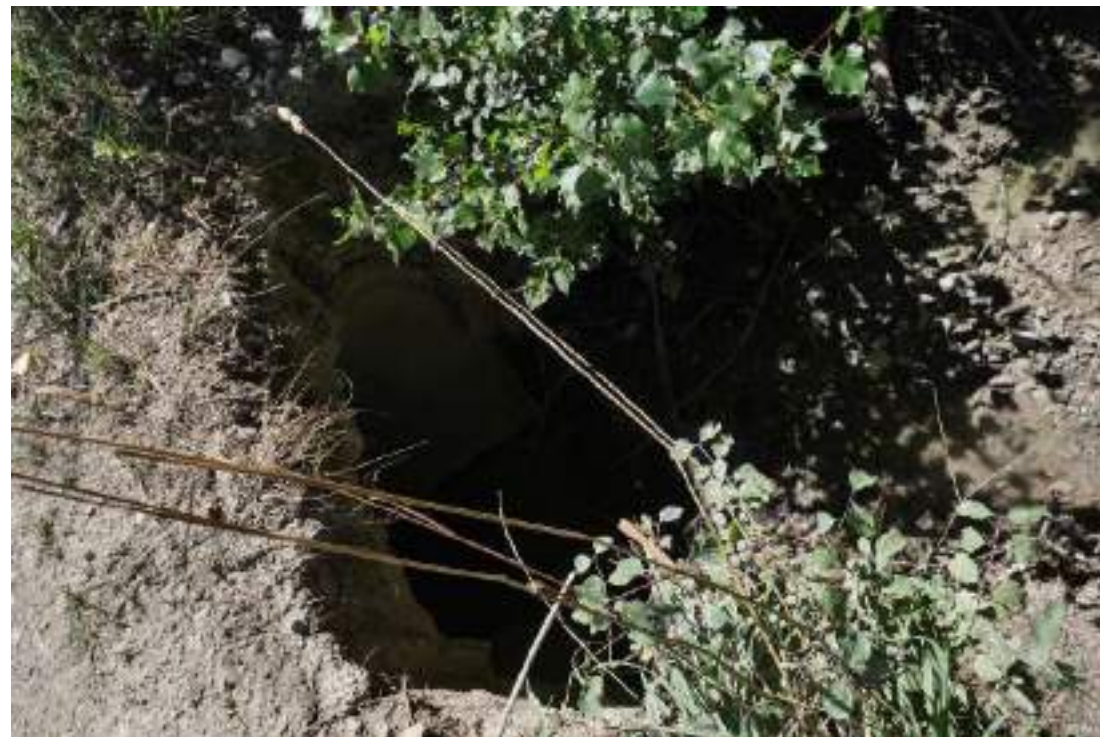
FIGURE 46 : BUSE SOUS LA PISTE D'ACCES QUI RETABLIT LE VALLON NORD
