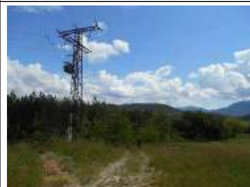
FIGURE 104 : LIGNE ELECTRIQUE AU SUD DU SITE
