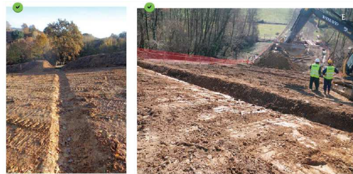
FIGURE 15 : EXEMPLE DE CUNETTE COLLECTANT LES ECOULEMENTS SUPERFICIELS
