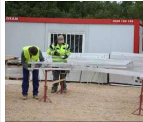
Base vie du chantier de Vinon-sur-Verdon
