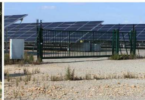
Portail et clôture
