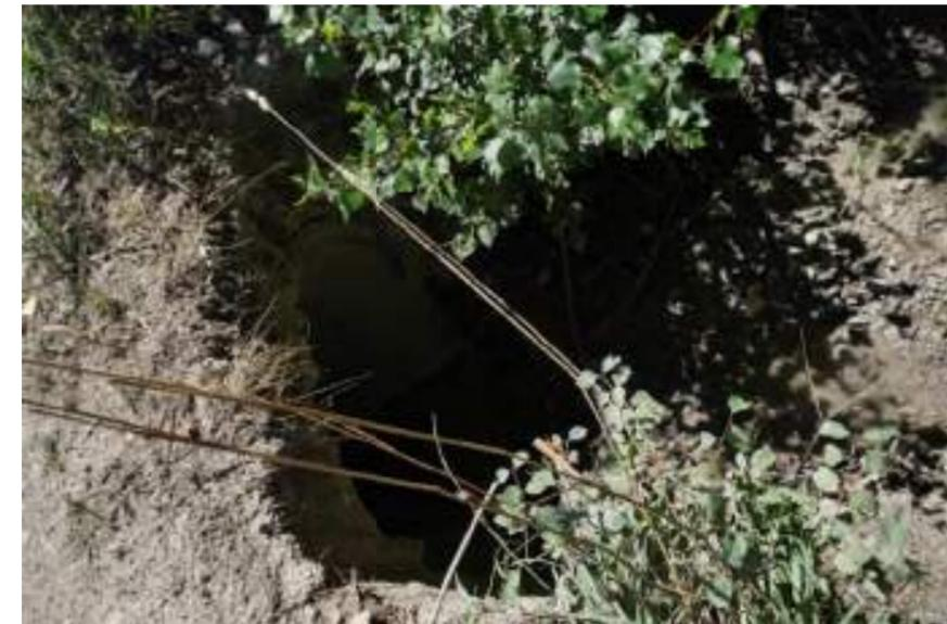
**Figure 26 - Buse sous la piste d'accès qui rétablit le vallon Nord (source : MOA)**
