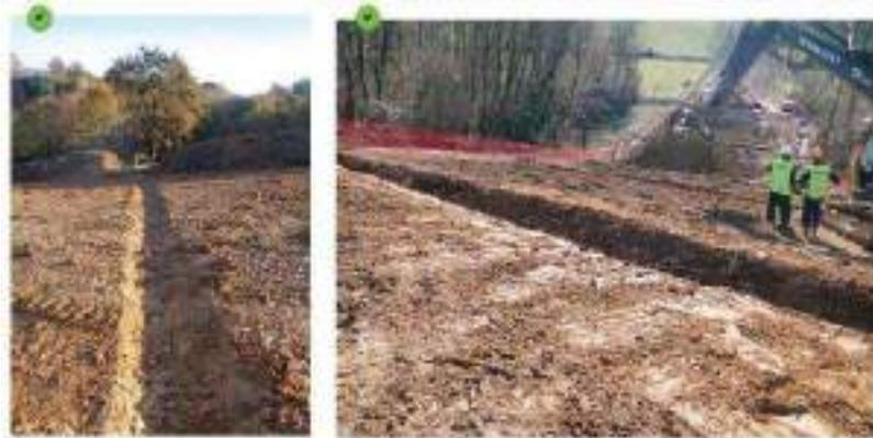
Figure 22 - Exemple de cunette collectant les écoulements superficiels (source : Guide technique AFB - Bonnes pratiques environnementales - Protection des milieux aquatiques en phase chantier - février 2019)
